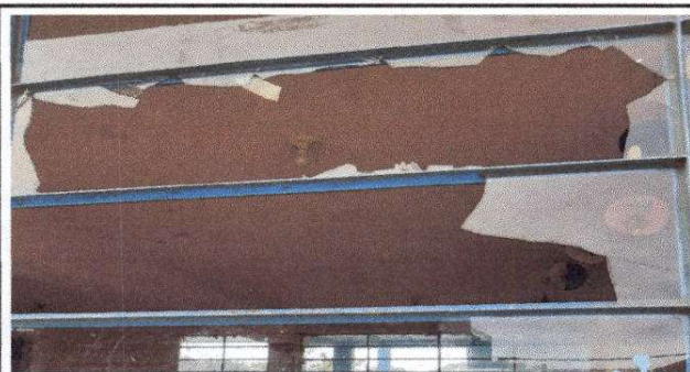
Foto 3: Sustitución de vidrios de las aulas
