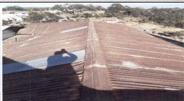
Foto 1: Cambio de techo de cocina y bodegas
