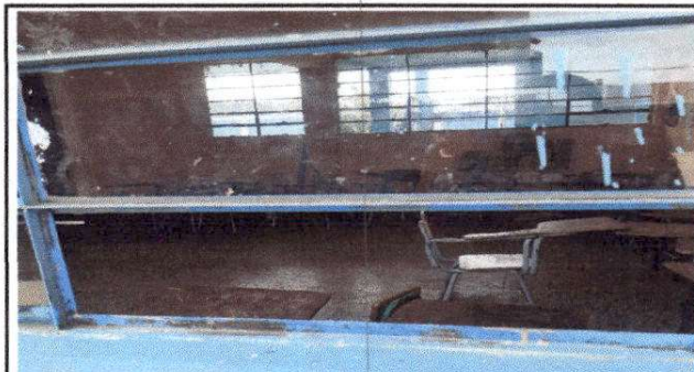
Foto 4: Sustitución de vidrios de las aulas
