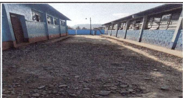
Foto 5: Torta de concreto en patio
