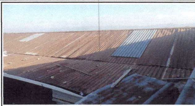
Foto 2: Cambio de techo de cocina y bodegas
